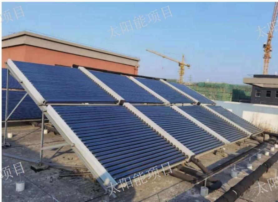
产品与建筑结合平板太阳能集热器，无论从整体外形、结构强度及规格尺寸均适合与建筑相结合，可直接流动在房顶上或嵌进屋面上，而且极易成为屋顶结垢的组成部分，和建筑浑然融为一体，因此平板集热器与建筑结合比真空管集热器更好一些。产品售后服务对平板集热器而言，由于热损较少运行温度一般低于60℃不轻易产生过热现象，故结垢较少，其排污主要通过水箱排污管加以解决。其主要维修工作在于定期清洗集热器盖板的尘土，若采用钢化玻璃则盖板的迎宛率会有效下降，由此可见平板集热器的使用寿命大于15~20年是没有题目标。真空管集热器由于运行温度比较高，忽然碰到冷热轻易炸管裂管，其次是祖空管与水箱或联箱链接是采用硅橡胶密封圈，炔塾触不好或以敷沙粒易发生渗漏现象，另外对于南北向竖排真空管工程或紧凑式真空管热水器而言，由于有些地方水质不好，真空管下部往往存在悬浮固体颗粒物沉淀，时间长了，管子采光和吸热受到影响，因此有些地方，使用3~4年后需将真空管抽出来进行清洗，维修工作量较大。真空管本身的质量的好坏，在很大程度上决定了集热器的质量，也严种影响热水工程的售后服务工作量。
